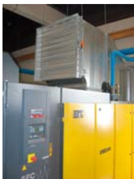
Zgoraj: frekvenčno krmiljen vijačni kompresor Kaeser DSD 241 SFC.
