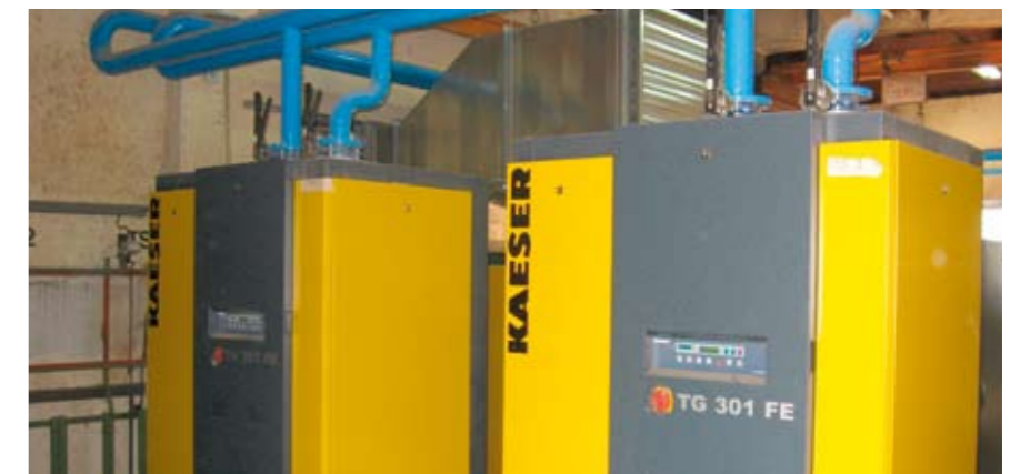
Zgoraj: energetska varčna hladilna sušilnika Kaeser TG 301 FE.
